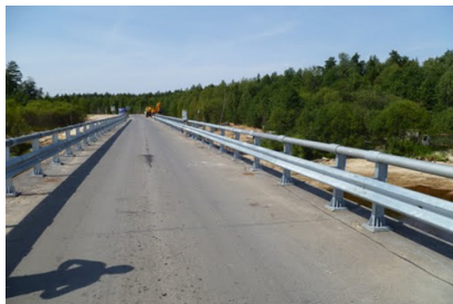
Новый мост через р. Керженец.
